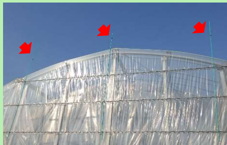
①ハウス妻面の支柱およびテグスの取り付け状況 材料費は、2,396㎡で1万5千円程度。 ▲の位置にテグスを結束。
