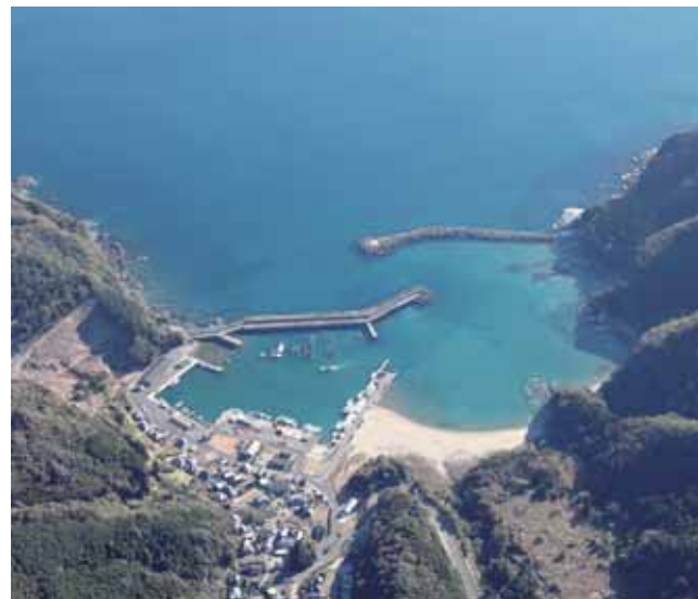
(直海地区) 令和2年11月撮影
