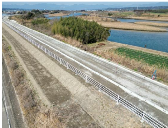
広域河川改修事業(一ツ瀬川:宮崎市)
