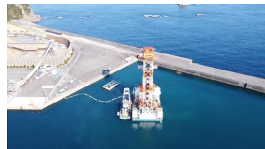
油津港東地区 岸壁(-12.0m)(県)
