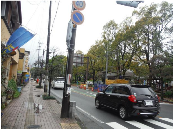
宮崎須木線 南俣工区（綾町） 無電柱化 （整備前）
