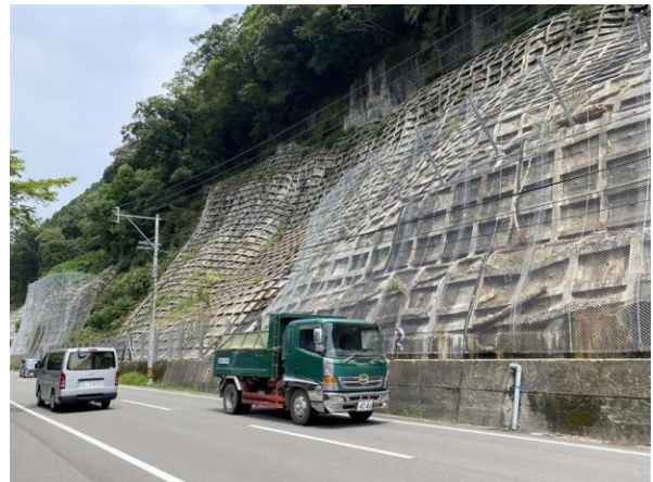
法面防災 （整備後）
