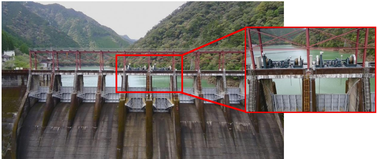
開閉装置更新工事(松尾ダム:木城町)
