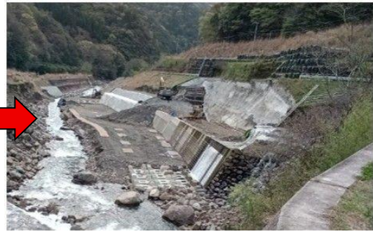
【復旧中】災害復旧事業(銀鏡川:西都市)
