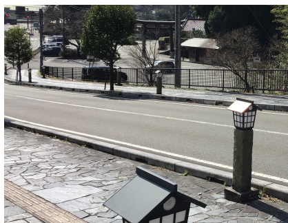
⑥景観に配慮した防護柵（高千穂神社付近）
