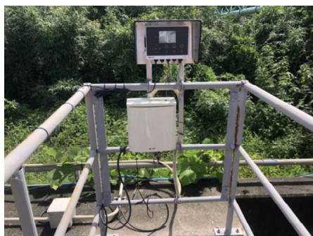
写真1 スマート汚泥自動制御装置
