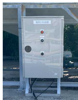
写真2 制御盤（独立型）
