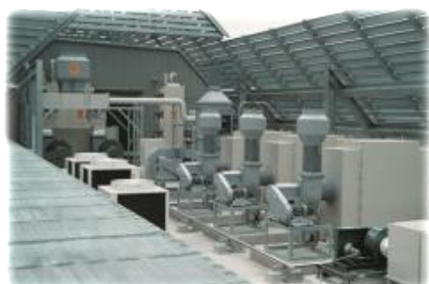
研究所排ガス処理装置導入例
