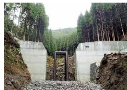
治山施設 (スリットダム)
