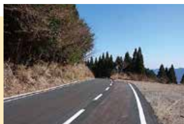
大型車両に対応した林道等の改良
