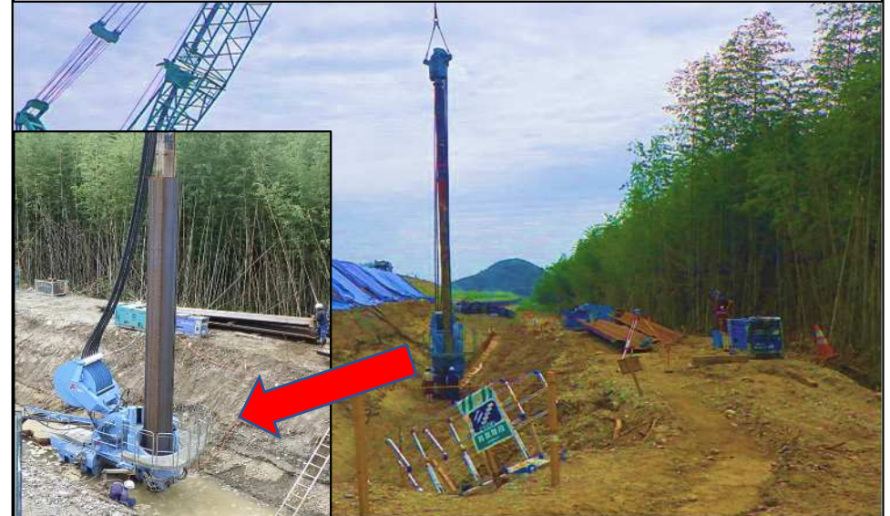
施工状況 (遮水矢板圧入)
