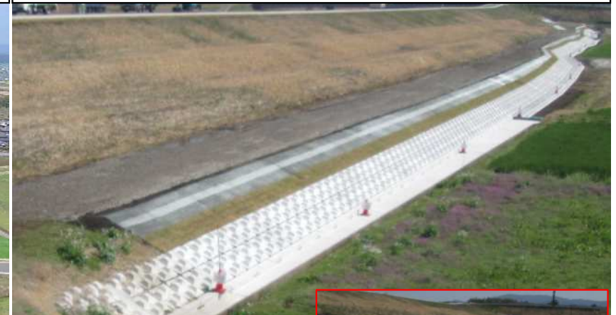
法尻補強対策 (近景)
