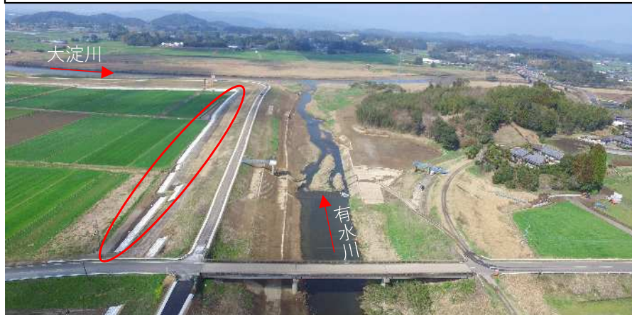
法尻補強対策 (全景)
