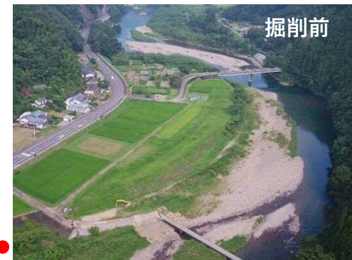
河道掘削箇所（R2施工）
