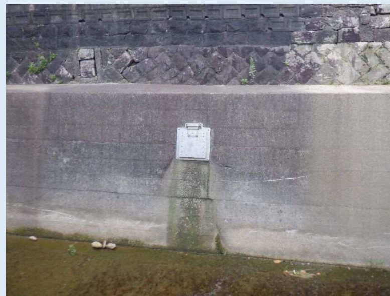
宮川内川【実施後】
