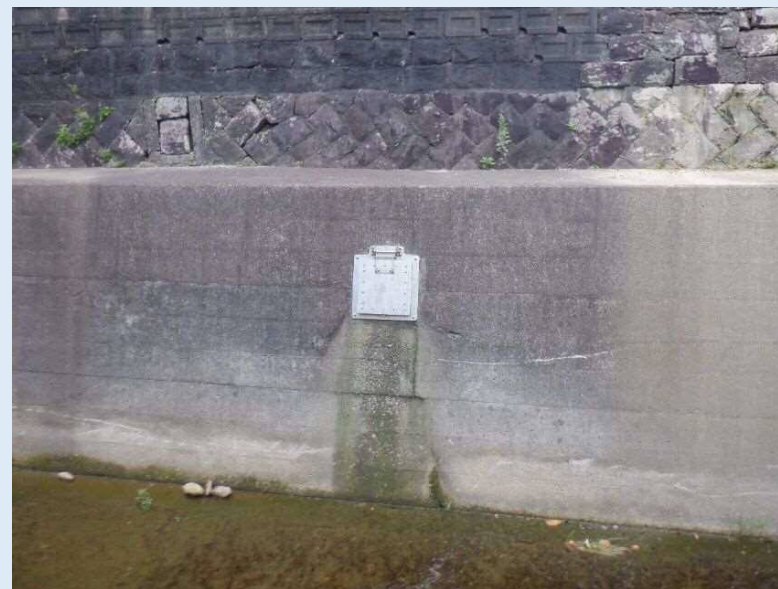
宮川内川【実施後】
