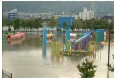
河川事業と公園事業の共同事業により、河川の洪水調整機能を備えた多目的遊水地として整備
