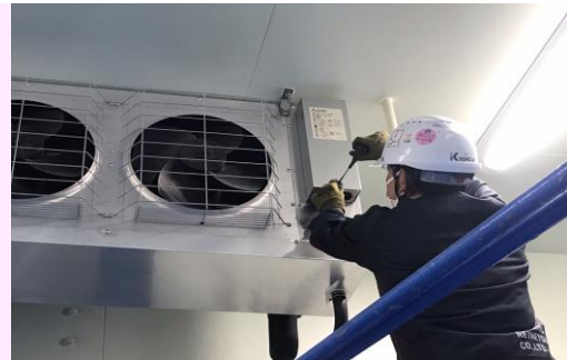
【冷却器設置作業】
