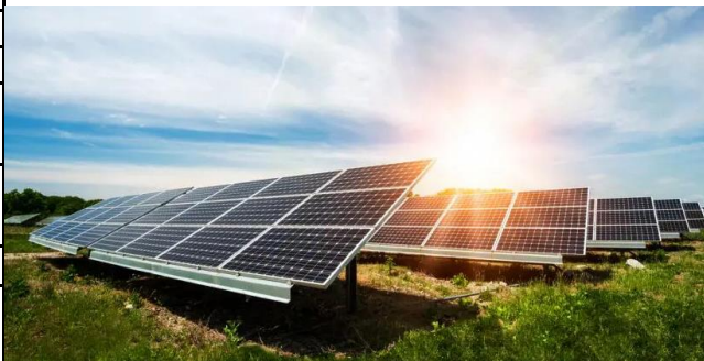
【太陽光発電工事イメージ写真】
