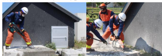
削岩機、エンジンカッター取扱訓練
