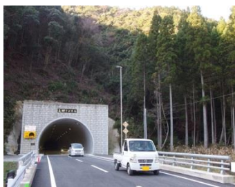
中山間地域に整備されたトンネル
