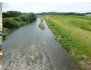
護岸整備された河川
