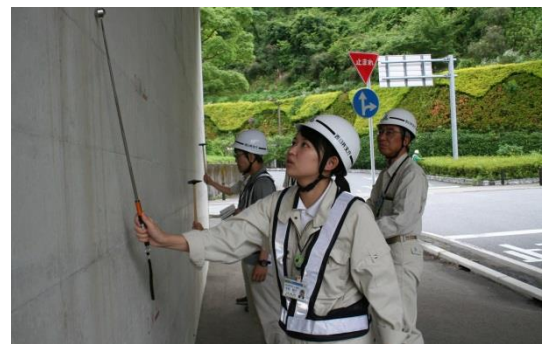
橋梁の定期点検
