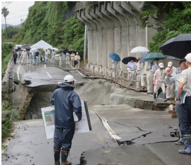
大雨により崩壊した道路の復旧
