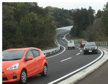
開通した快適な道路
