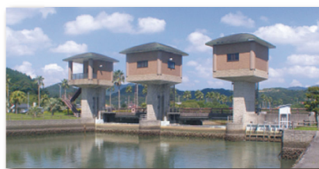
■庄手川防潮堰
