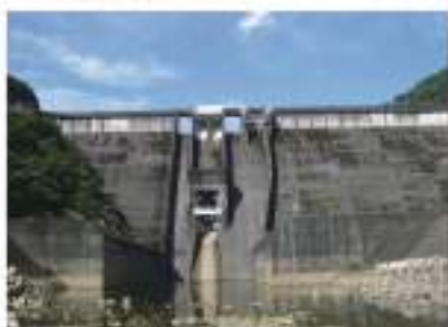
●設備更新 (放流設備改良工事)
