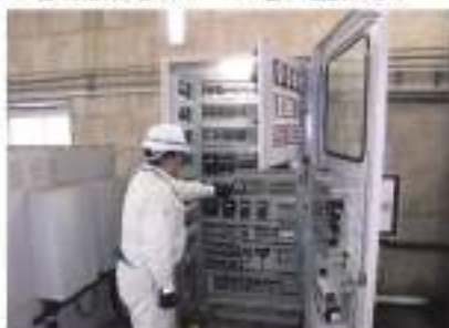
●設備点検(ゲート電力盤点検)
