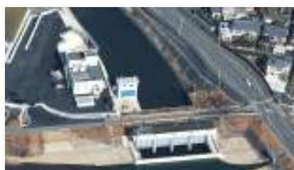
■蛇谷排水機場
