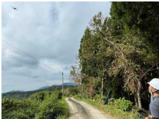
ドローンによるレーザー計測
