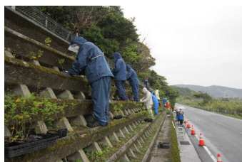
2-(1) ボランティア活動による 国道の植栽管理
