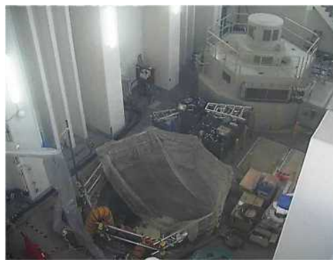
④ 改良施工中
