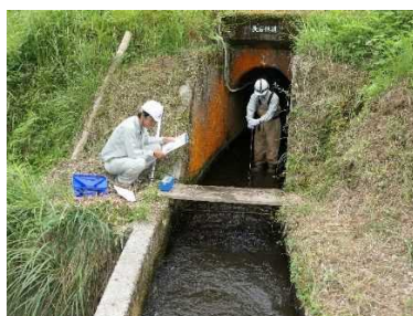
水路の流量測定
