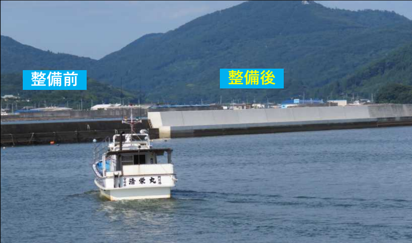
北防砂堤（嵩上げ）
