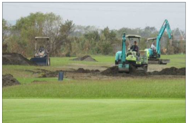
7月の復旧作業の様子
