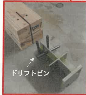
写真4 筋交い耐震壁の柱脚部に用いられたドリフトピン接合部（綾中学校）
