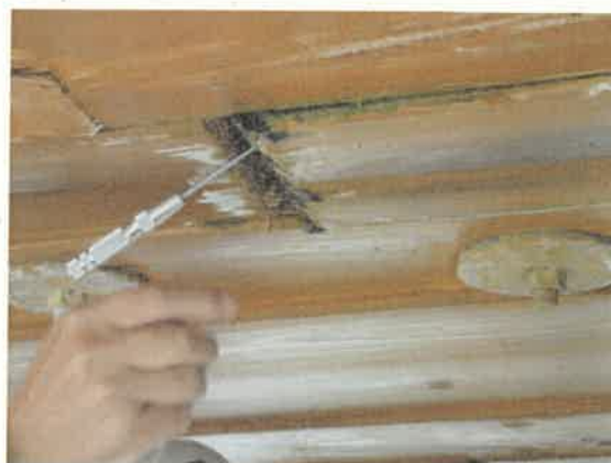
写真2 ドライバーによる触診点検
