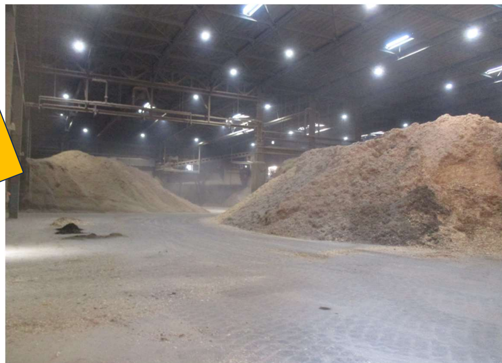
(約14,200㎡の燃料倉庫内)
