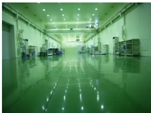
大型クリーンルーム4棟 (クラス10000) 20t・5t親子クレーン各3基 20t・10t親子クレーン各2基
