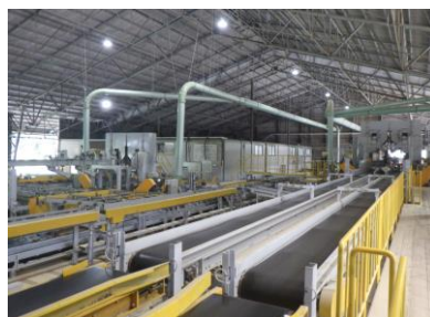
木材加工流通施設整備 (中大径材加工施設)
