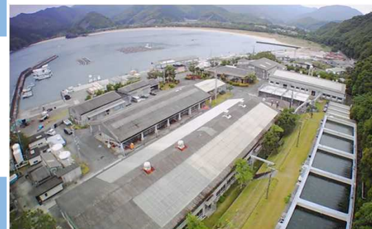
【現在の種苗生産施設】
