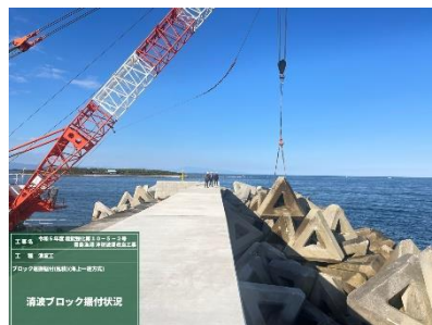
図19 防波堤の整備 (青島漁港)
