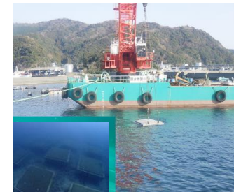
図3 藻場礁設置工事
