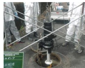
図23 集落排水施設の保全工事(富士漁港)
