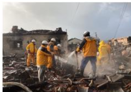
【輪島市消防団による消火活動】
