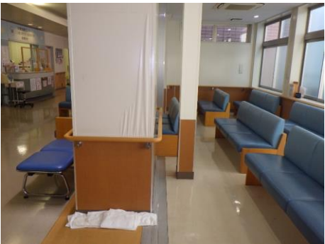
■病院局の被害（雨漏り）
