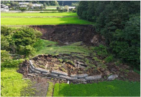
■農地（水田）の崩壊と 水路の埋没
