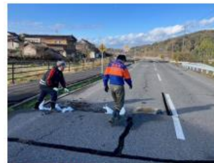
【輪島市消防団による亀裂の入った 道路補修の様子】
