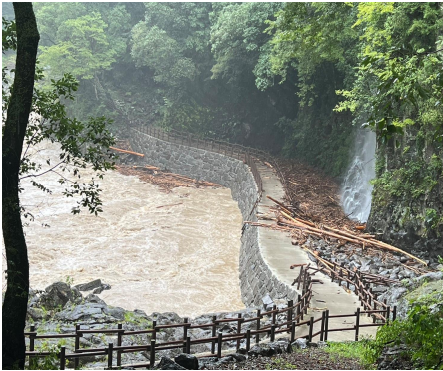
■高千穂峡九州自然遊歩道の被害 （高千穂町）
