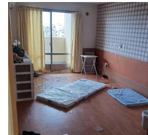
■特別養護老人ホームの 窓ガラスの破損 (宮崎市)
