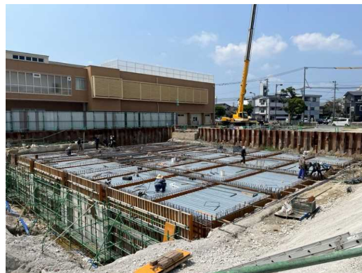
③緊急汚水槽整備
