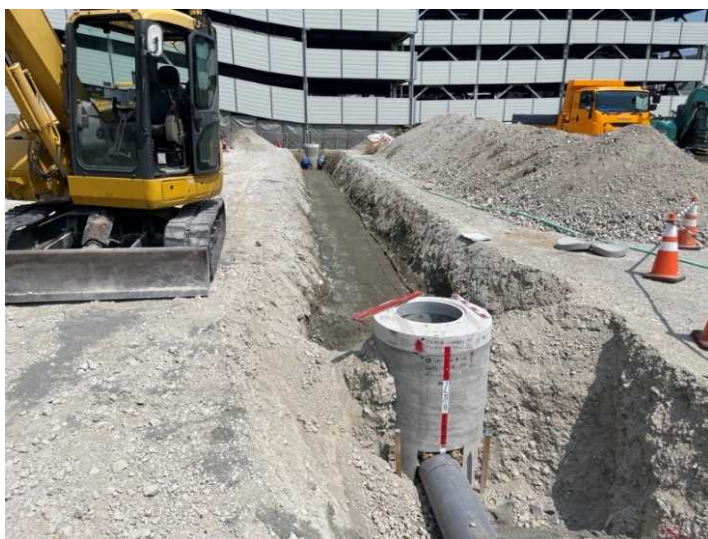
②屋外配管・駐車場の整備
