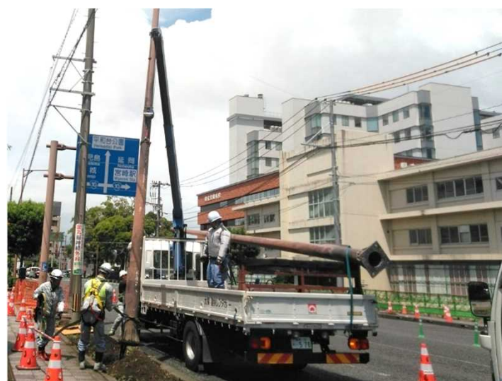
④国道269号線交差点整備
