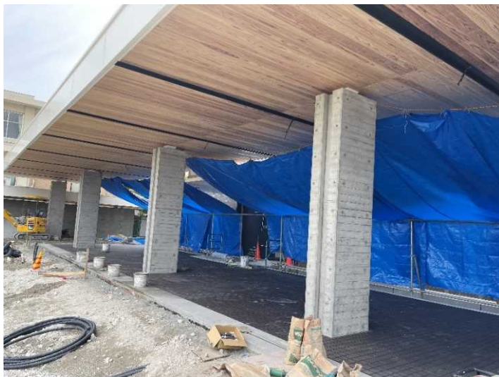
①玄関庇の整備
