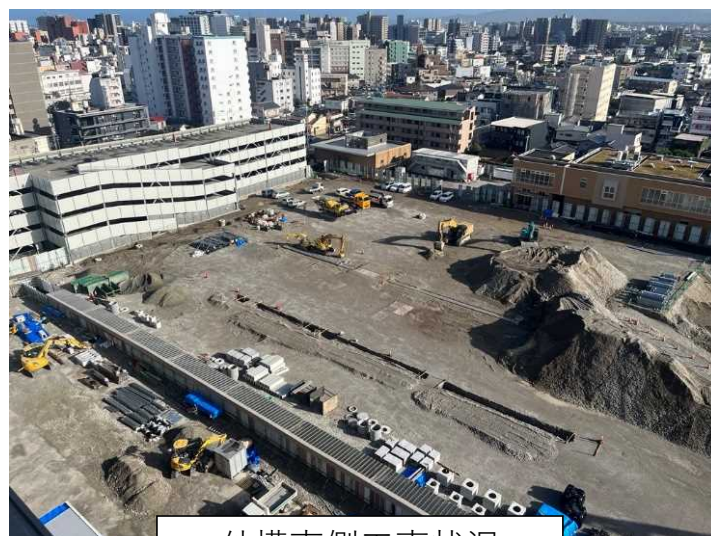
外構東側工事状況
