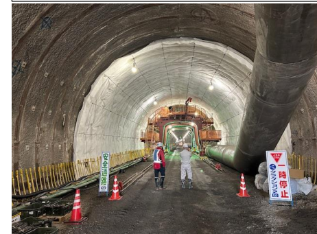
トンネル施工状況 (1工区)
