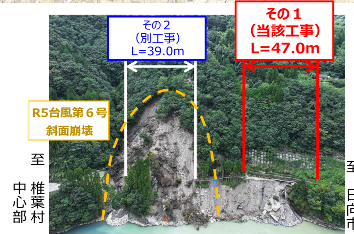
令和5年台風第6号による斜面の崩壊状況
