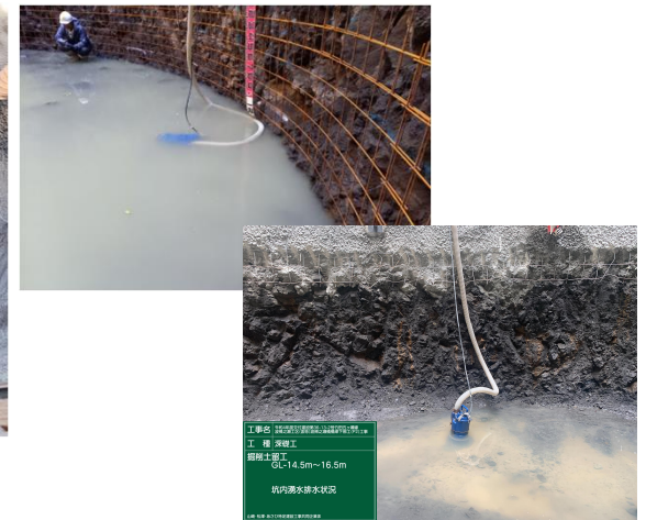
【ポンプ排水状況】
