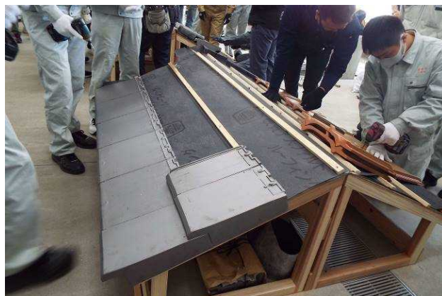
かわらぶき作業の様子
