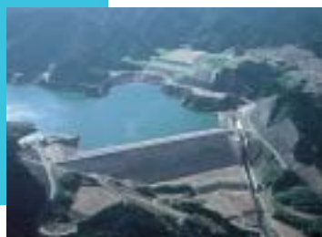
天神ダム（田野町）
