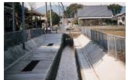
混住化した地域を流れる用水路 (西都市・杉安用水路)
