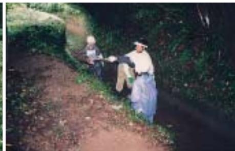
水路の土砂上げ
