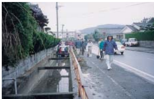
土地改良区は定期的に農業用排水路等の維持管理作業を実施している。（宅地排水も受け入れ）
