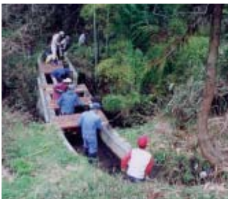
中山間地域では、何十kmに及ぶ水路管理を組合員総出で行っています。
