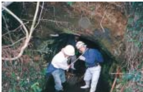
隧道の土砂上げ
