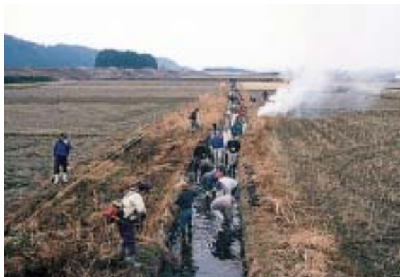
山角地区の住民参加による排水路浚渫作業
