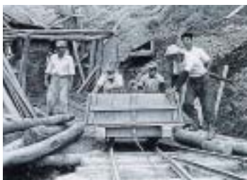
人力による導水路工事（昭和初期）
