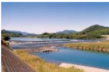
現在の岩熊頭首工
