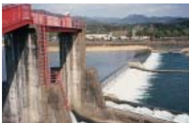
現在の近代的な杉安頭首工
