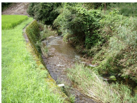
図 1 St.1 源流付近
