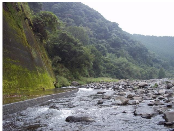
図 6 St.5 綾第二発電所
