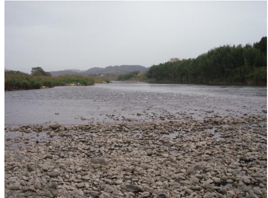
図 4 St.3 柳瀬大橋
