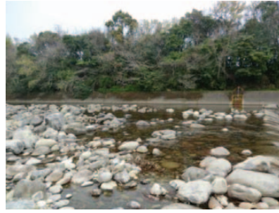
図3 St. 2 川北南橋
