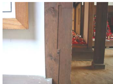
柱の継ぎ手(金輪継ぎ)
