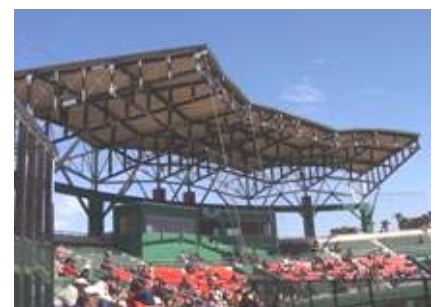
図-4 完成した日南天福球場内野スタンド
