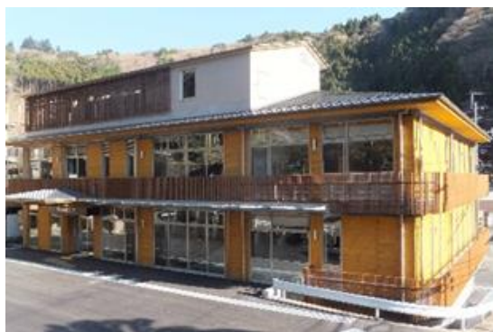
（西米良村新庁舎 全景）
