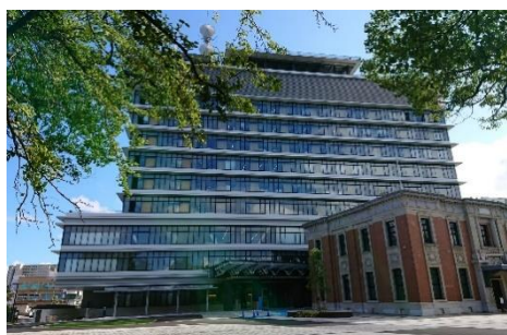
(宮崎県防災庁舎 全景)
