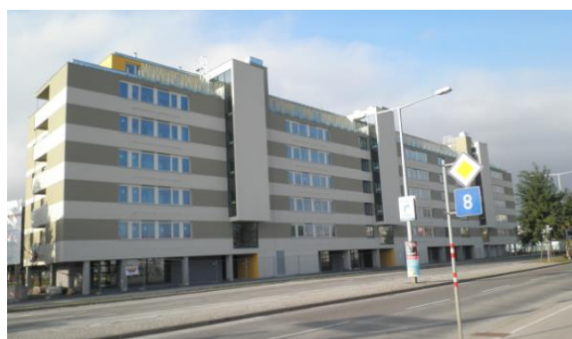
図3 CLTによる建築物 (ウイーンの6階建て集合住宅)
