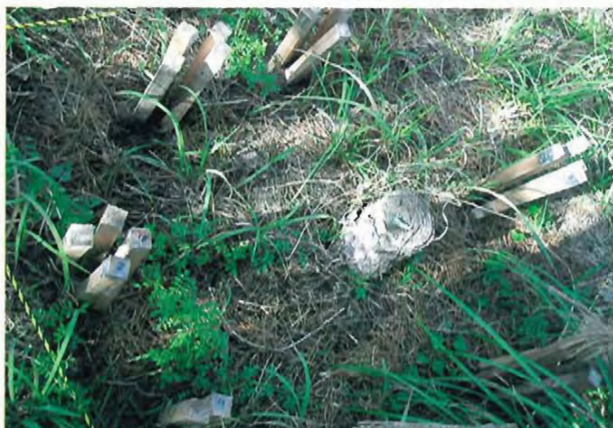
写真1 杭の埋め込み状況
