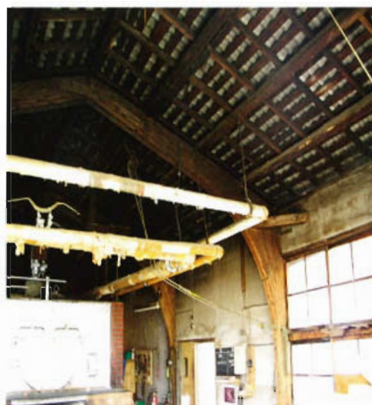
約45年前に建築されたスギ集成材によるボイラー棟 (写真：丸十産業株式会社)
