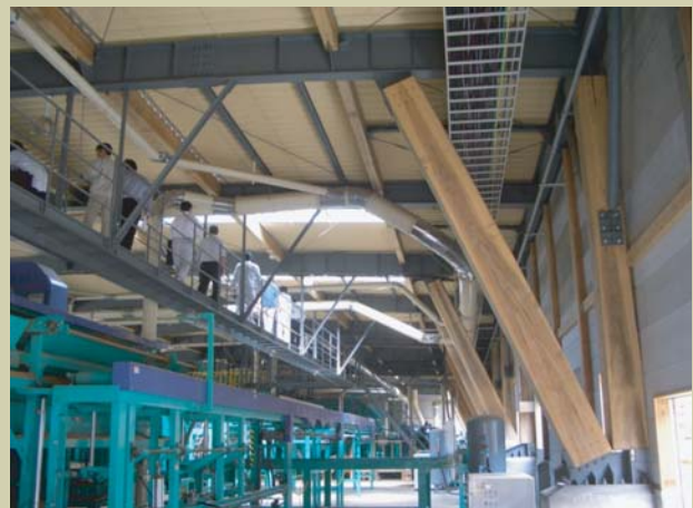
写真2 竣工後の内観
