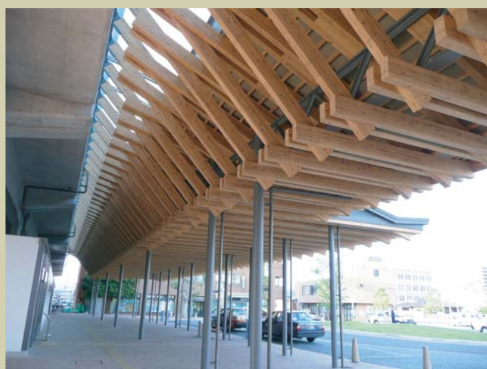
写真1 日向駅舎のキャノピー部 (E55-F200(内層L30)集成材を使用)
