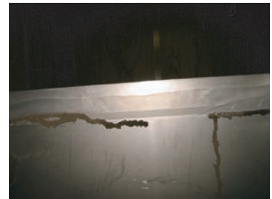
図1 フィルム型バリアーで蟻道が阻止されている様子
