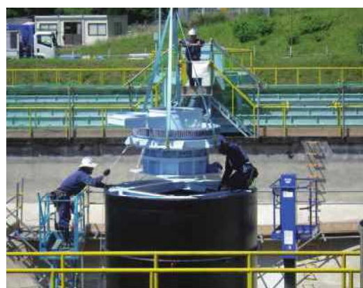
新しい高速凝集沈殿装置の据付作業
