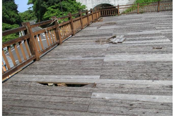
2 トロピカルバレー木製階段 損壊
